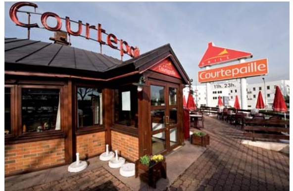
Courtepaille, Rosny sous Bois
