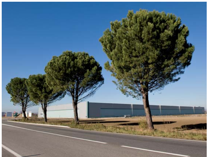
Plateforme logistique, Bollène
